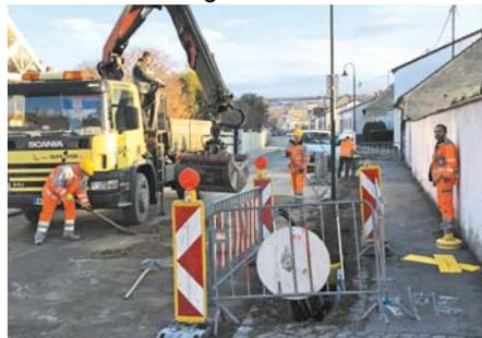
hinter der Raika und beim Schloss auf der Hauptstraße befinden sich die beiden ARU-Verteiler. Bei allen Straßen- und Gehsteigsanierungen werden seit drei Jahren und laufend Leerverrohungen in Abstimmung mit NÖGIG mitverlegt. Auch heuer errichtete die NÖGIG mit Unterstützung der Gemeinde Hausanschlüsse in der Bahnsteiggasse, Graben, Brunnenweg und der Hauptstraße bis zum Schloss.
